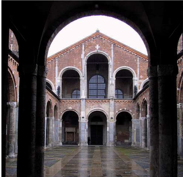
Sant'Ambrogio, la celebre basilica milanese vista dal cortile d'ingresso.
