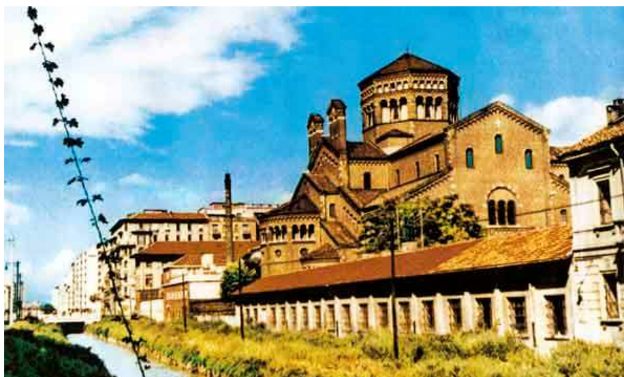
L'abside di Sant'Agostino vista dal canale non ancora coperto, diventato poi via Melchiorre Gioia.
