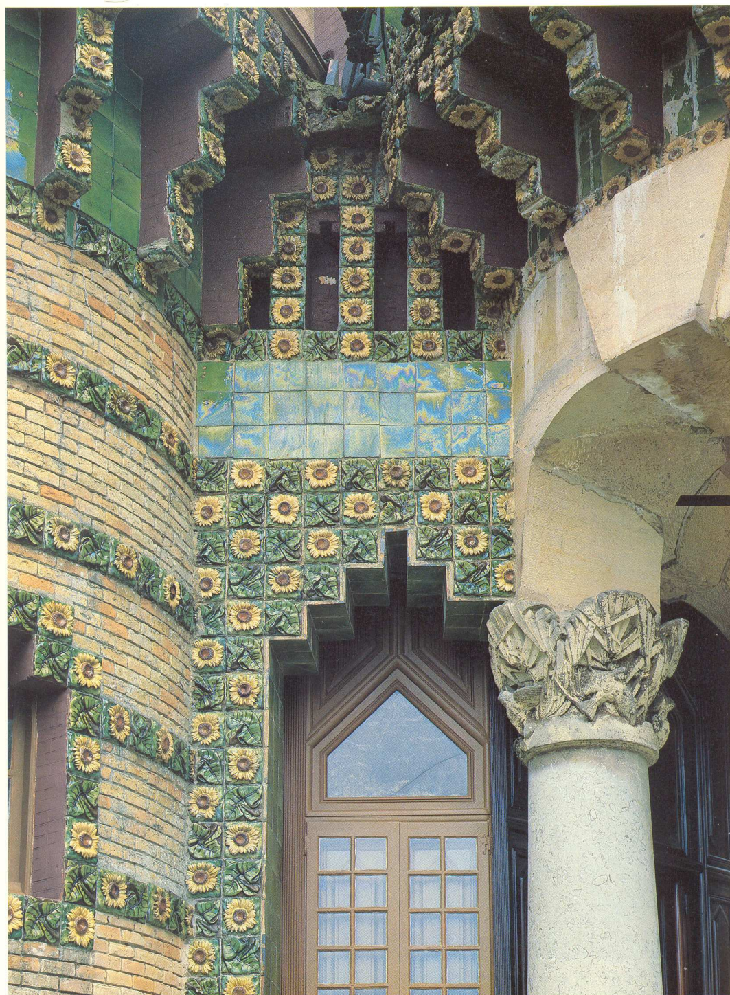
Particolare dell'ingresso della villa El Capricho
