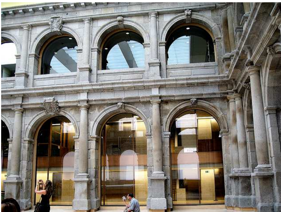
Il chiostro come appare a restauro ultimato
