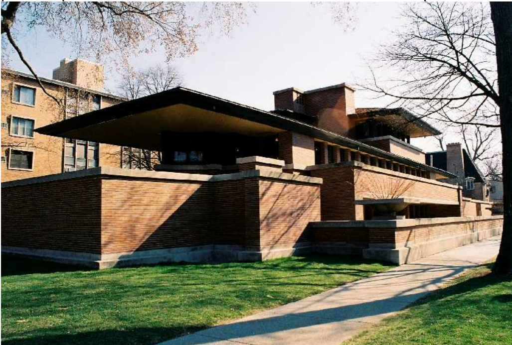
Fig. 12 – Capolavoro dello stile Prairie è la Robie House , del 1908.
