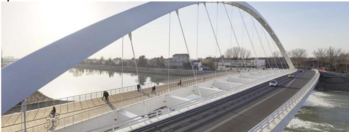
Fig. 1 – Ponte Cittadella sul fiume Tanaro ad Alessandria. Completamento: anno 2017
